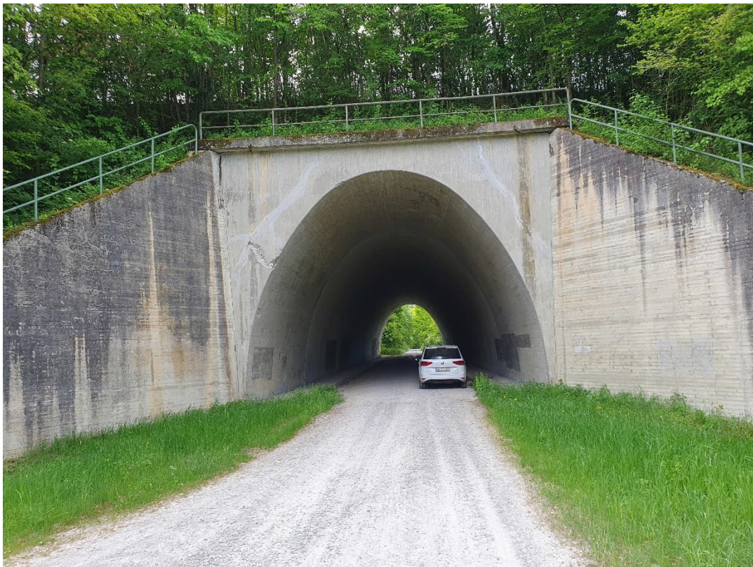
Ansicht von Norden auf das Bestandsbauwerk
